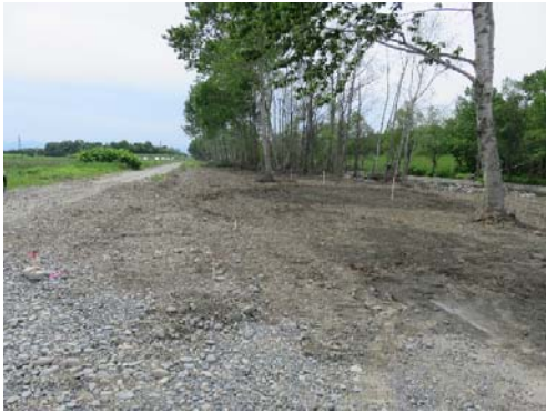
測量・播種後の現地状況（下流側から）
