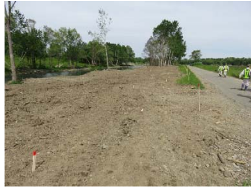
測量・播種後の現地状況（上流側から）
