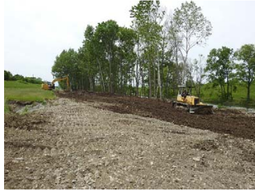
建設機械による土砂撤去・整地風景
