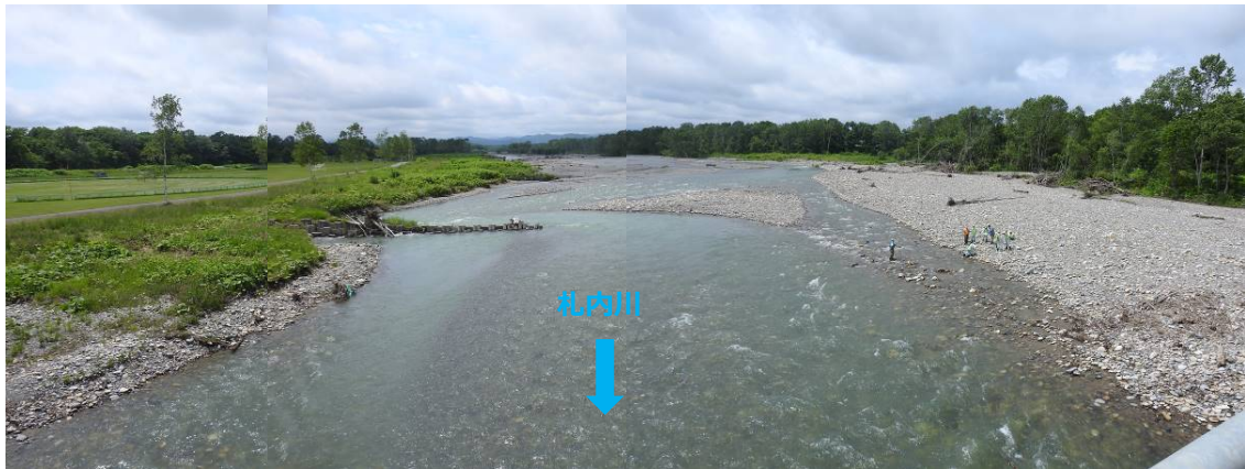
中札内橋から上流方向_横断測量を行っている箇所の全景
