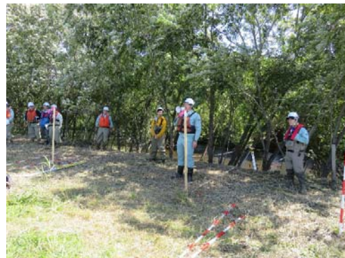
測量作業等に協力して頂いた北開水工の皆様
