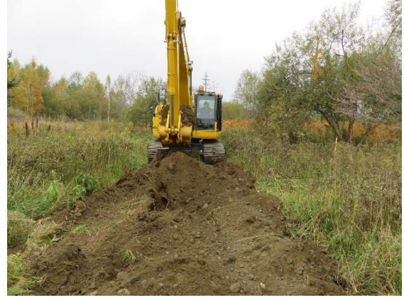
バックホウ0.7m 3 （立米）による表土の天地返しの様子
