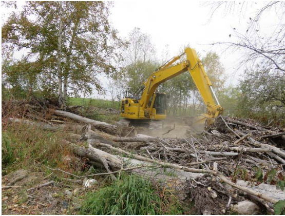
既存散策路の復旧（流木撤去）の様子
