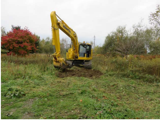
バックホウ0.7m 3 （立米）による表土の天地返しの様子
