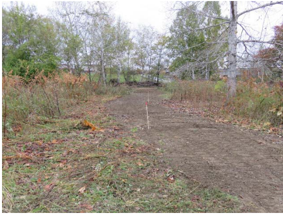
散策路の整備後（写真番号④）
