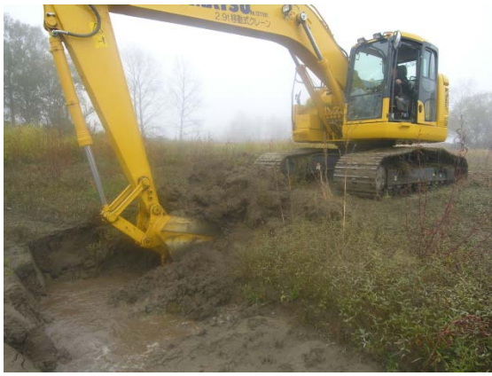
バックホウ（0.7m 3 ）による湿地の掘削状況 十勝川寄り
