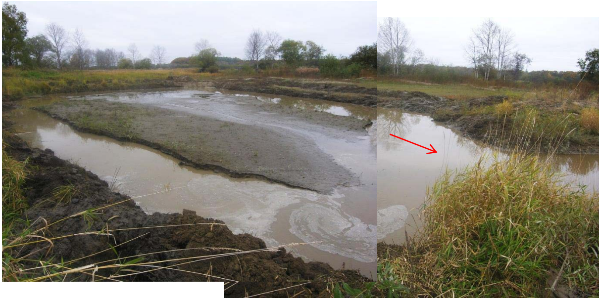
掘削完了全景
