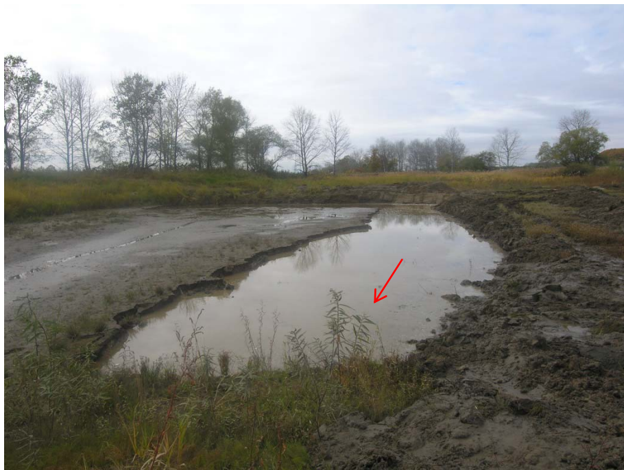
掘削全景__十勝川寄り
