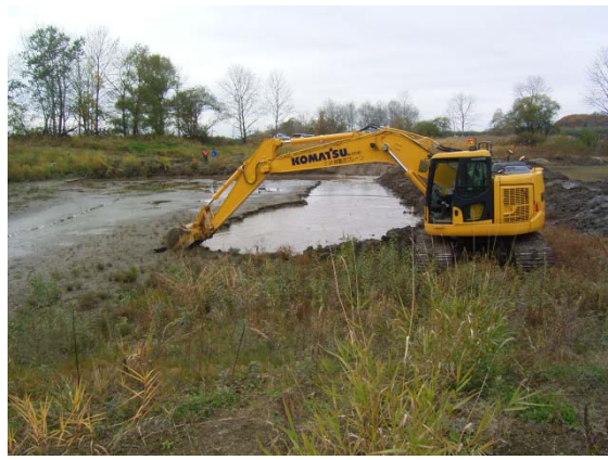
バックホウ（0.7m 3 ）による湿地の掘削状況 十勝川寄り
