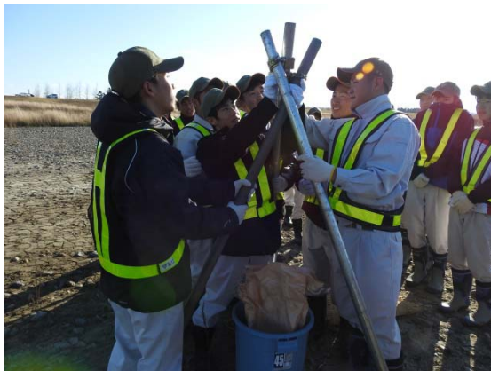
高校生による設置作業風景
