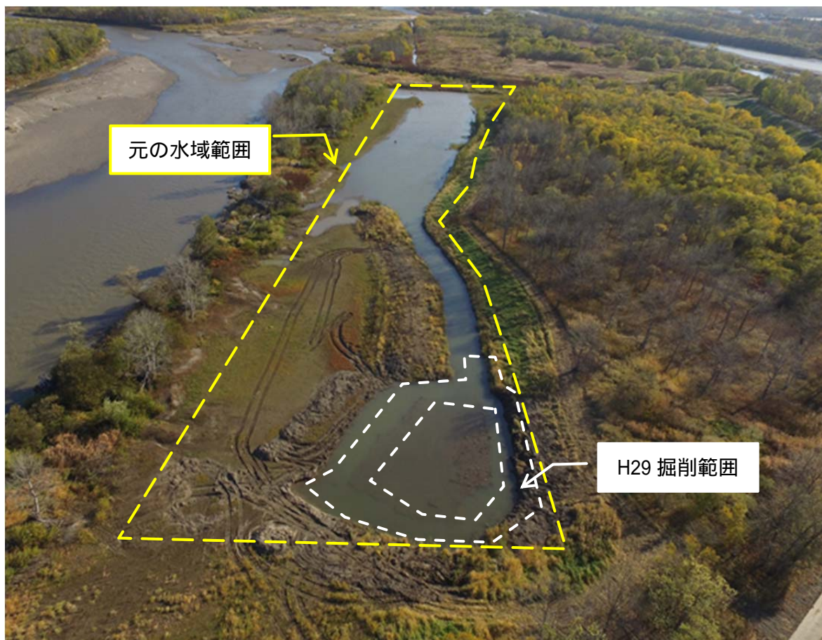
昨年 H29 掘削後の状況（平成 29 年 10 月 24 日撮影）
