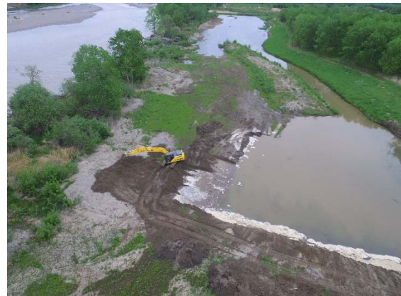
H30.5.19 掘削の様子
