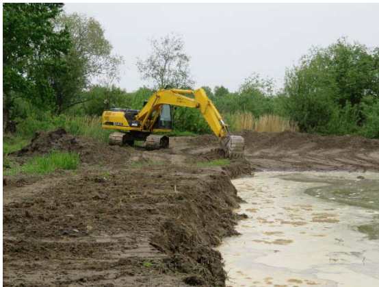
H30.5.18 掘削の様子
