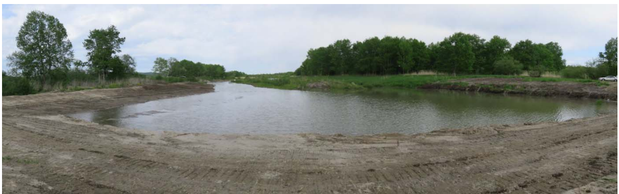
H30.5.20 掘削後の湿地状況
