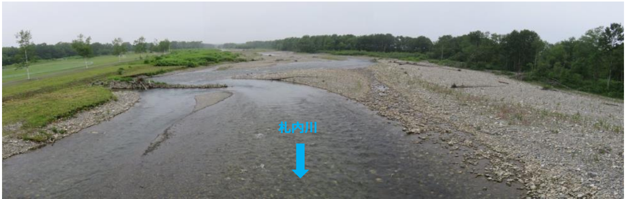
中札内橋から上流方向_横断測量を行っている箇所の全景
