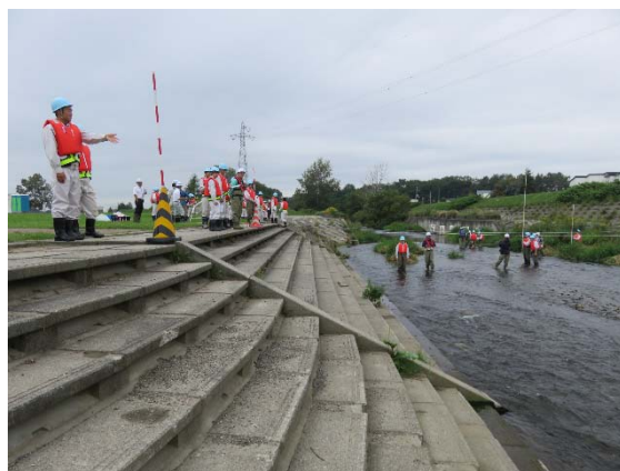
浮子による流速測定の様子
