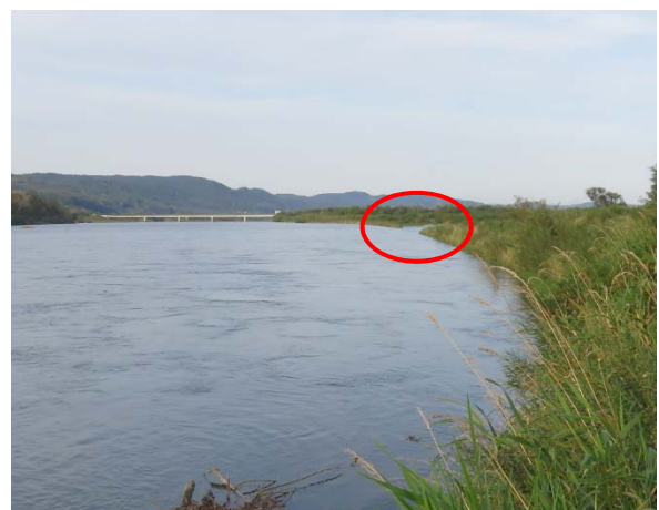
低水護岸の被災箇所
