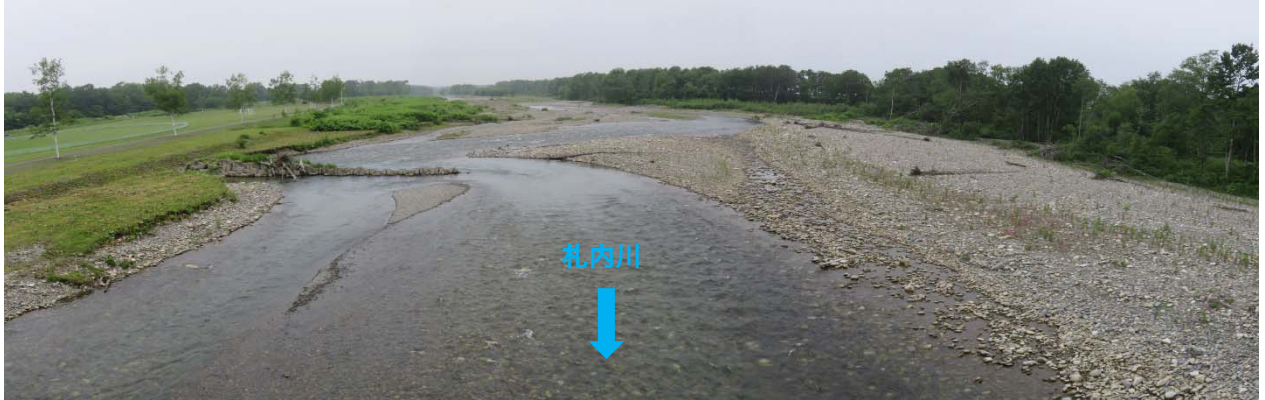
中札内橋から上流方向_札内川ダムからの放流前の状況 (H30.6.25)
