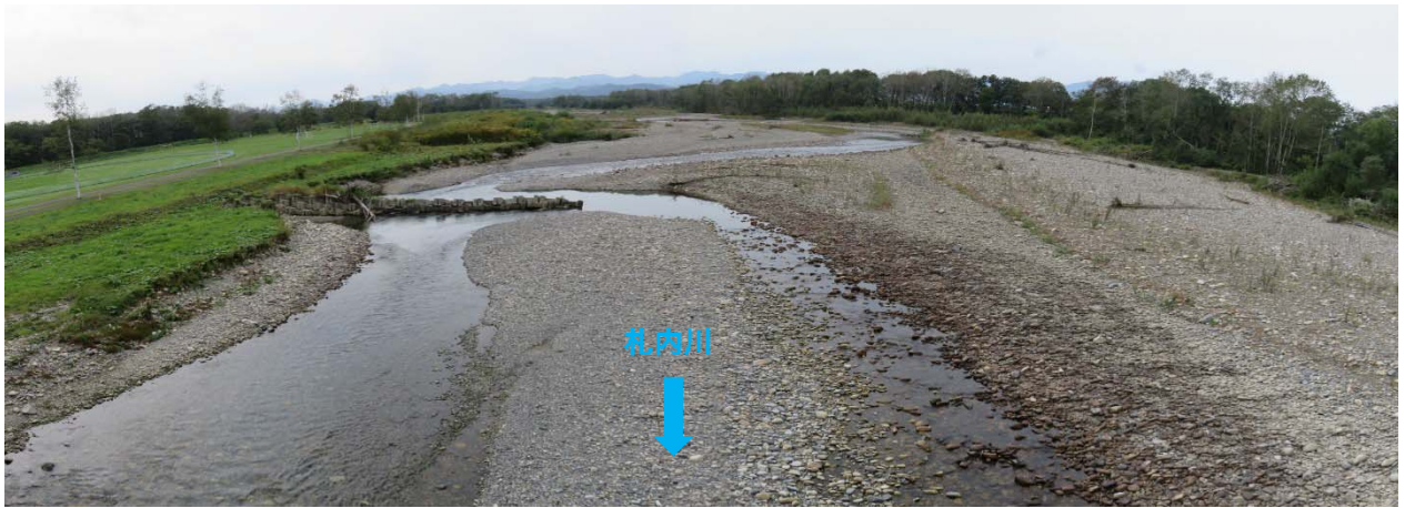
中札内橋から上流方向_札内川ダムからの放流後の状況 (H30.9.25)
