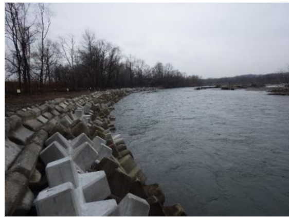
応急工事で行った護岸（根固めブロック）
