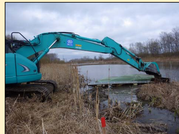
水域に埋まっていた屋根撤去状況
