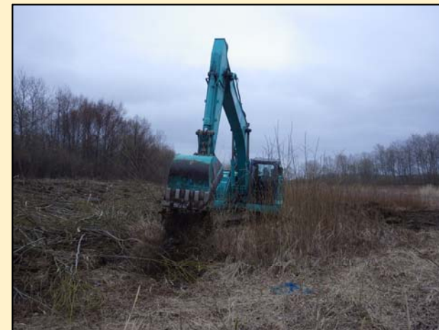
ヤナギ覆土状況
