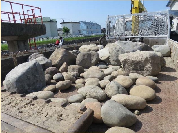
搬入された自然石・玉石
