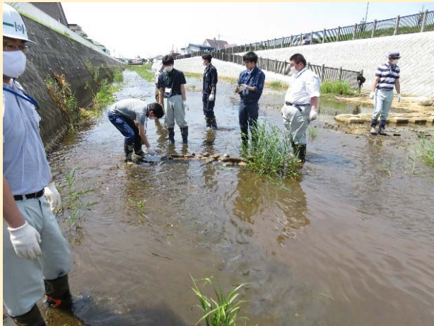
玉石設置状況
