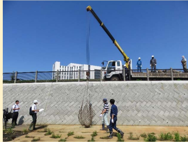
自然石・玉石を降ろす状況
