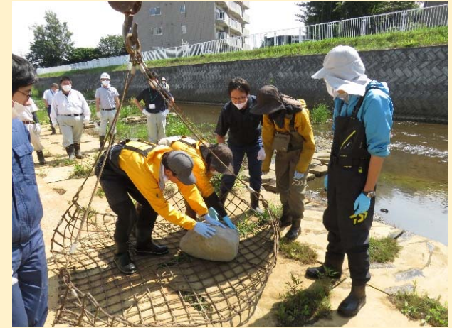
自然石設置状況
