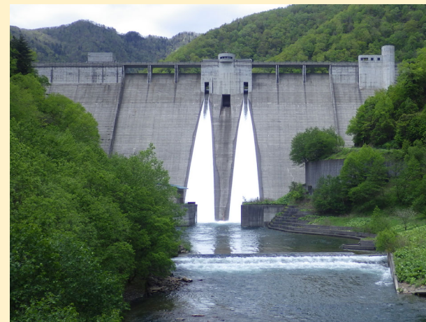
○札内川ダムからの放流状況
