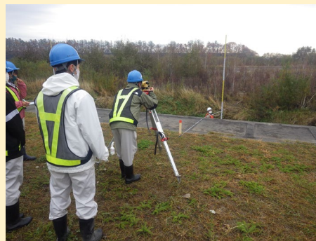
横断測量の状況
