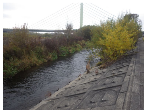
実技箇所（上流方向）
