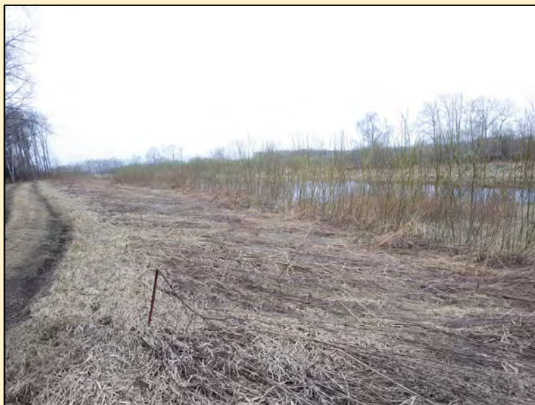
上流側除去前
