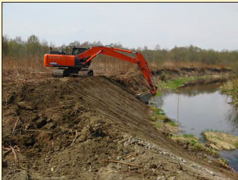
管理用道路整備状況
