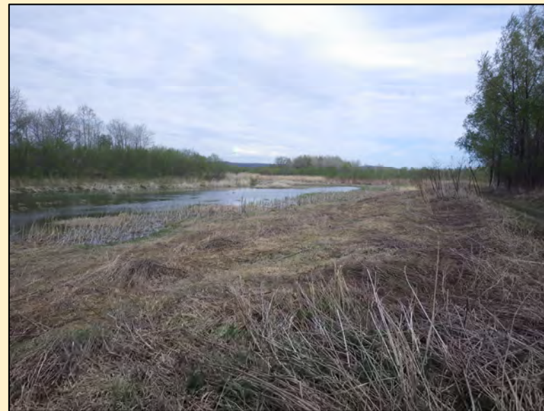
下流側除去後
