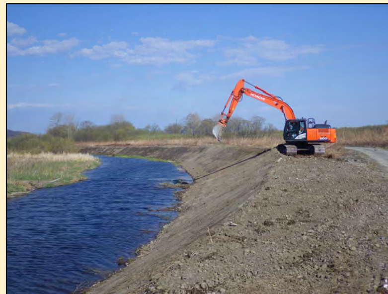
管理用道路整備後状況
