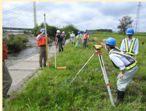
横断測量の状況
