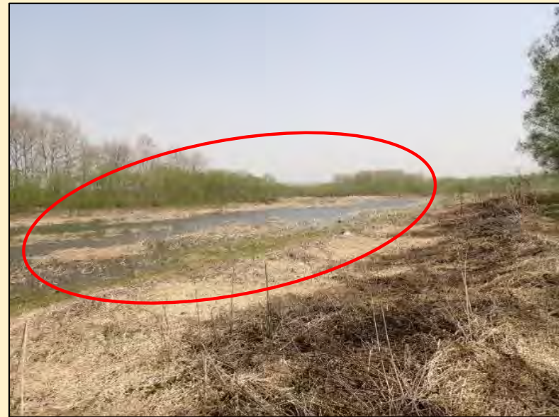
上流側除去後
