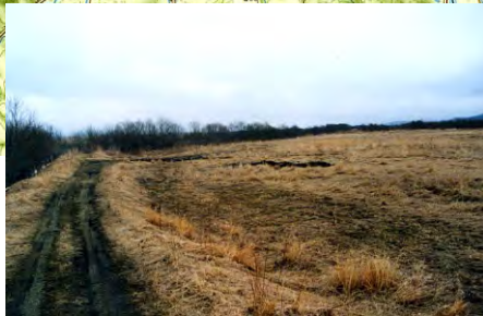
平成11年（1999年）掘削前
