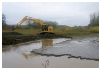
人工湿地の造成 Construction of a marsh
