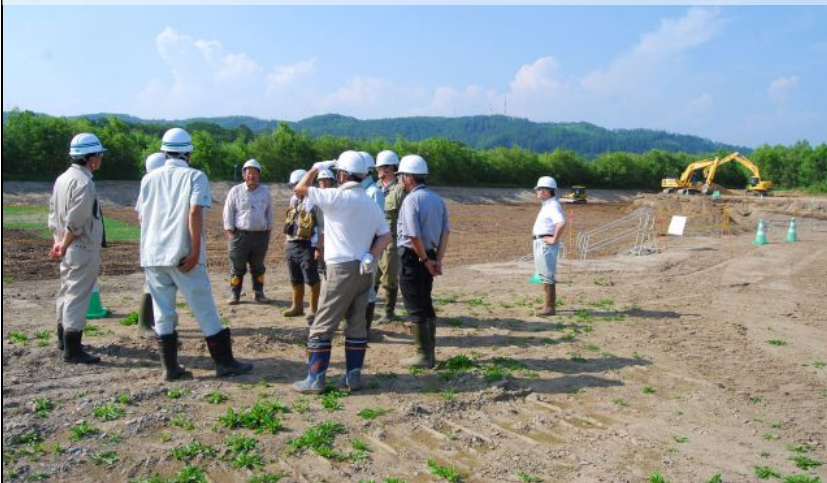
3.十勝川途別川合流点付近工事見学
