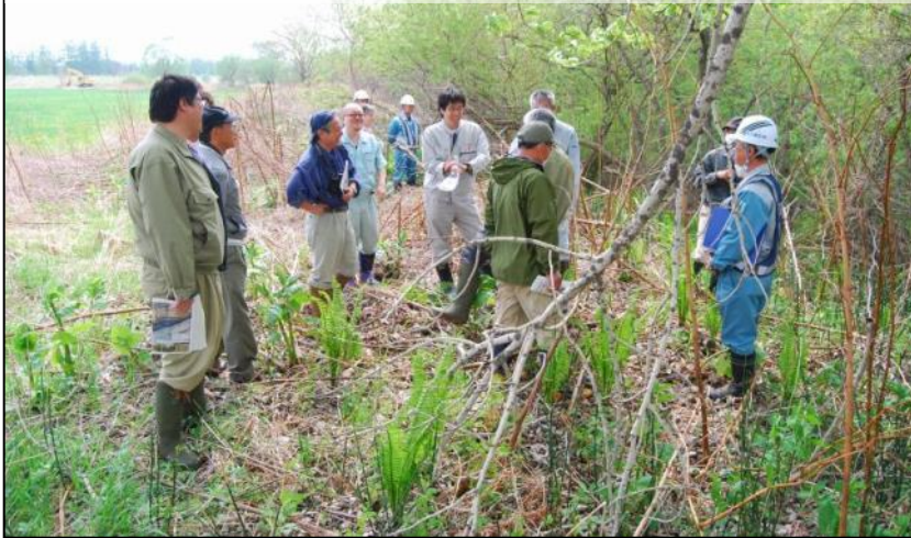
1.十勝川右岸途別川合流点付近工事箇所(施工中)見学
