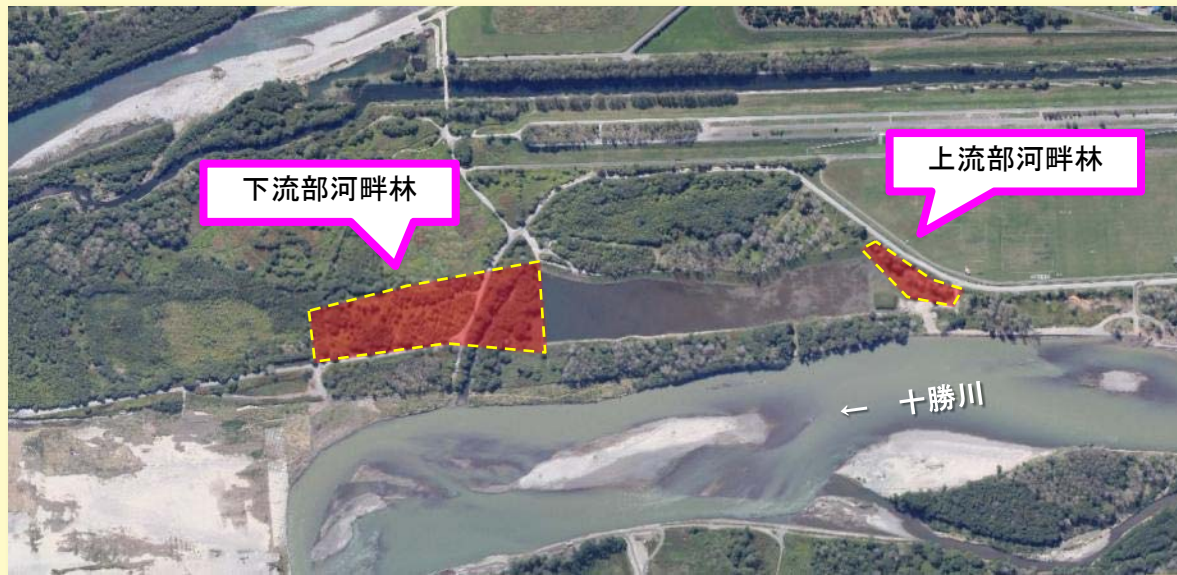
現地確認箇所
