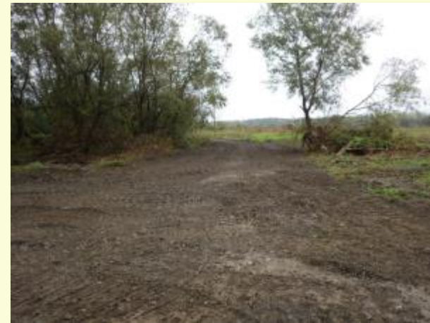
道路復旧完了
