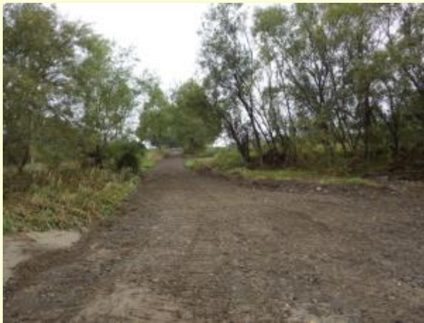
道路復旧完了
