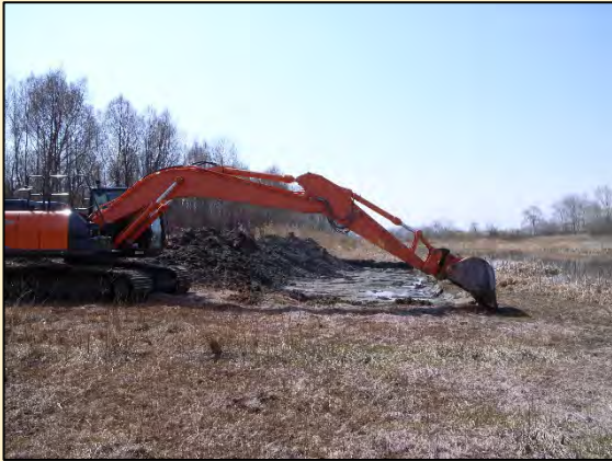
ガマ生育面積拡大のための掘削
