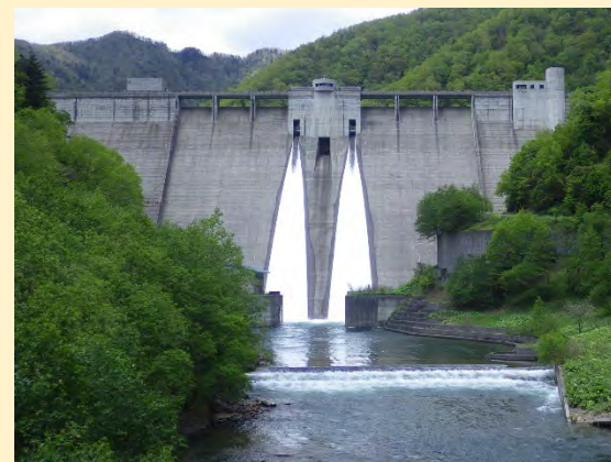
○札内川ダムからの放流状況
