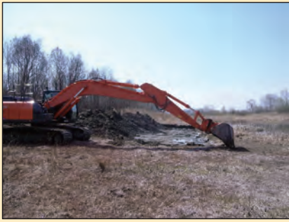
ガマ生育面積拡大のための掘削
