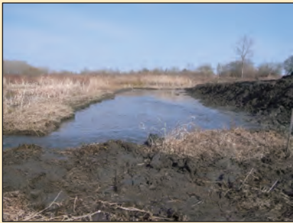
ガマ生育範囲拡大のための掘削後
