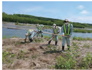
レーキによる表土掻きの様子
