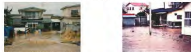
十勝太市街地の浸水状況(浦幌町) 大津市街地の浸水状況(豊頃町)
