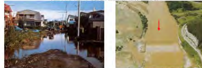
市街地の浸水状況(帯広市) 千代田堰堤の被災状況(池田町)
