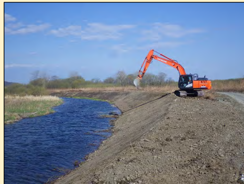
管理用道路整備後状況
