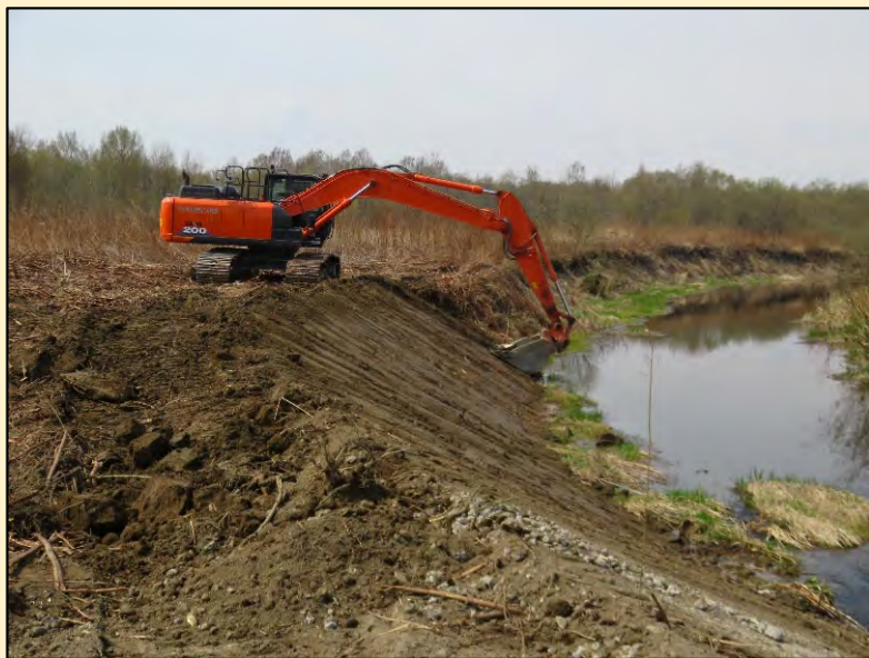
管理用道路整備状況
