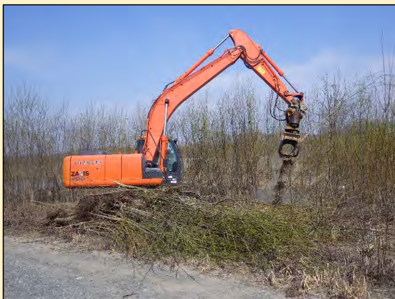
ヤナギ幼木除去状況
