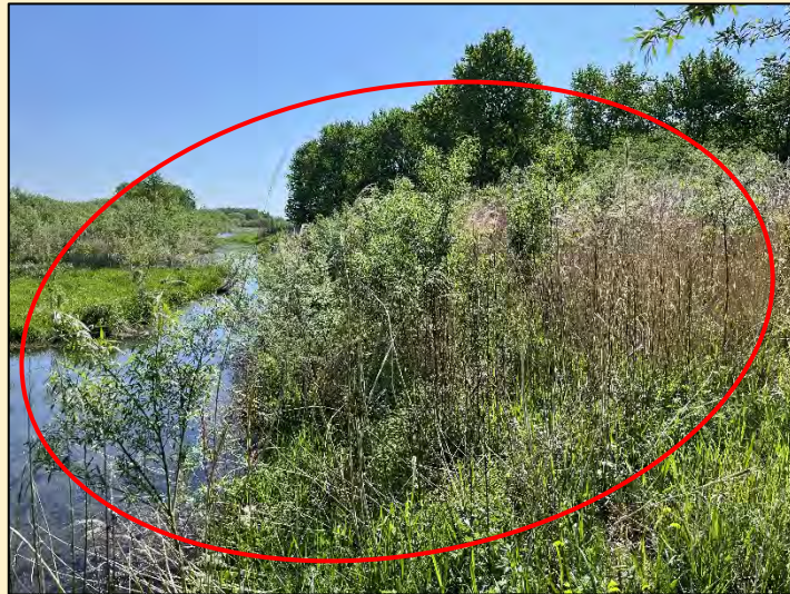
上流側除去前
