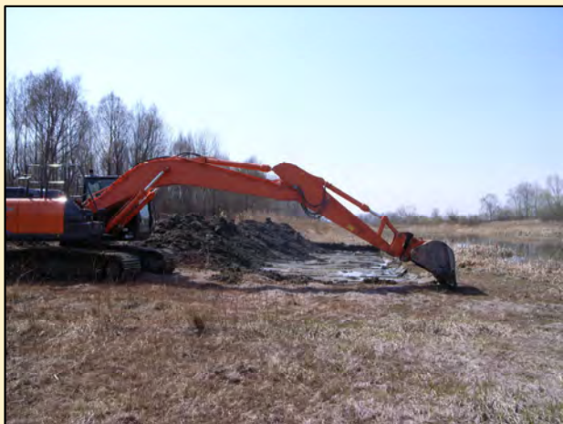
ガマ生育面積拡大のための掘削
