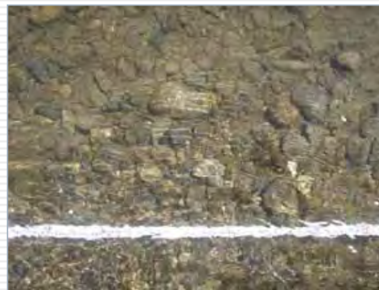
礫径3～7cm程度の浮石(46.1KP周辺)
