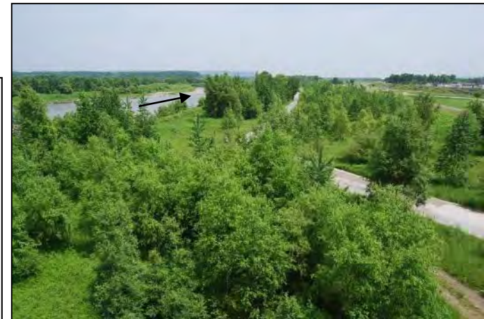
①十勝大橋下流右岸(築堤側)
