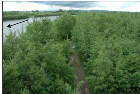
②十勝大橋上流左岸(川側)
