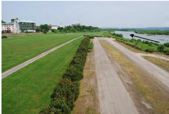
①十勝中央大橋下流左岸(築堤側)
