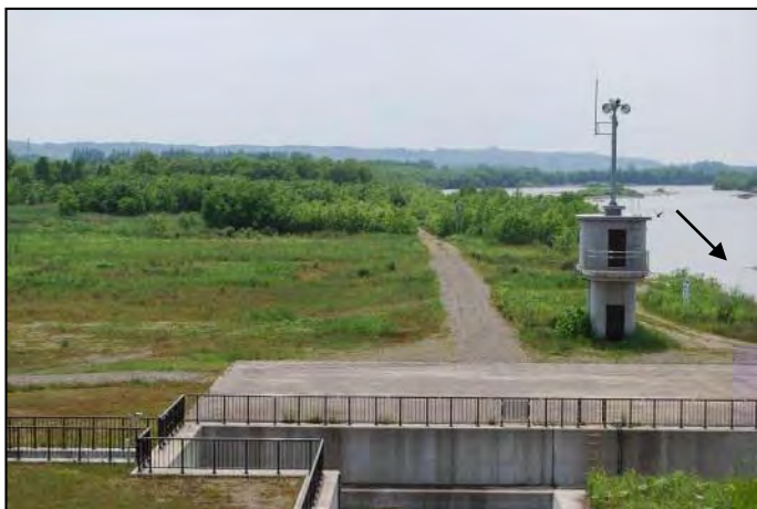
①千代田新水路上流右岸(築堤側)
