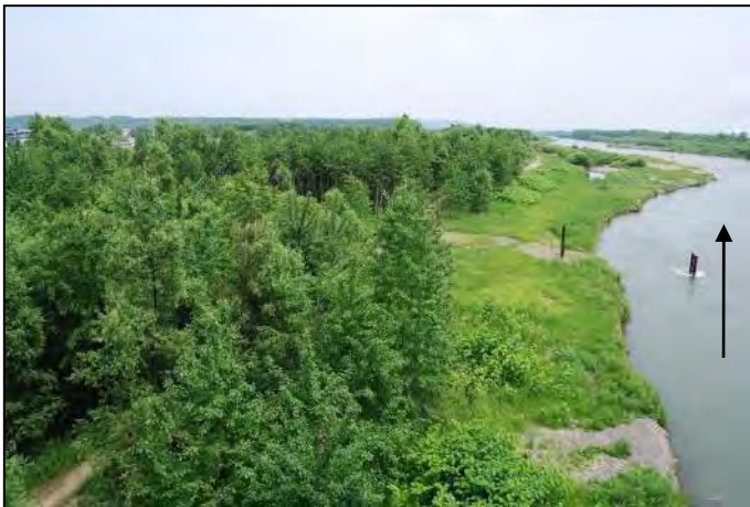
④十勝大橋下流左岸(川側)
