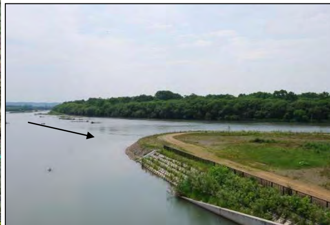
③千代田新水路上流左岸
