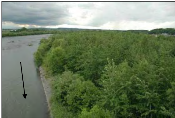
①十勝大橋上流左岸(川側)
