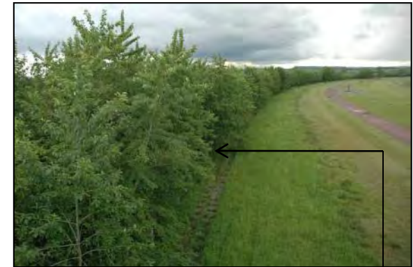
③十勝大橋上流左岸(築堤側)
