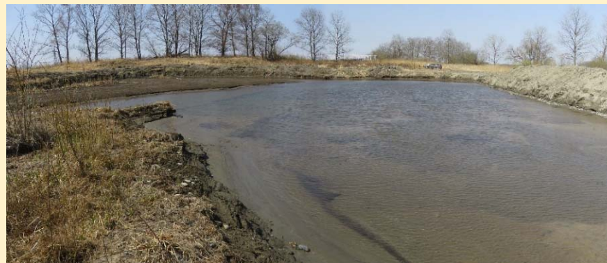
掘削後：湿地上流左岸の水域
