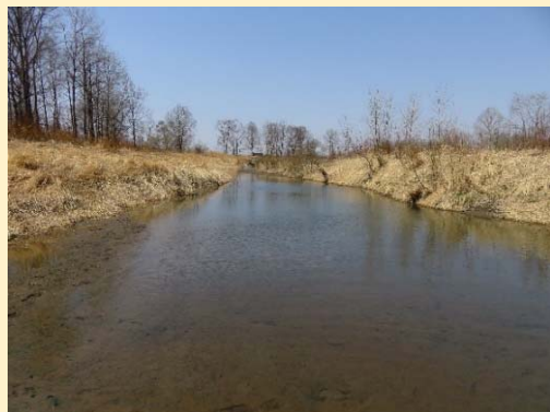
狭窄水路の状況（湿地中島部の右岸）
