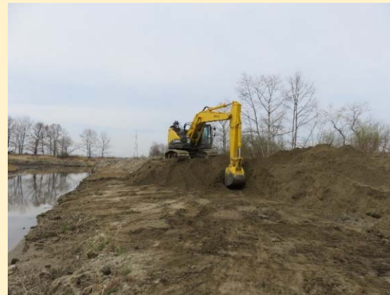
ヤナギ幼木に対して掘削土による覆土の様子
