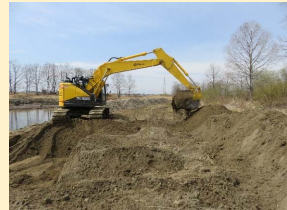
ヤナギ幼木に対して掘削土による覆土の様子
