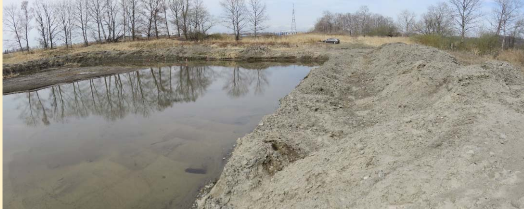
掘削後：湿地上流左岸
