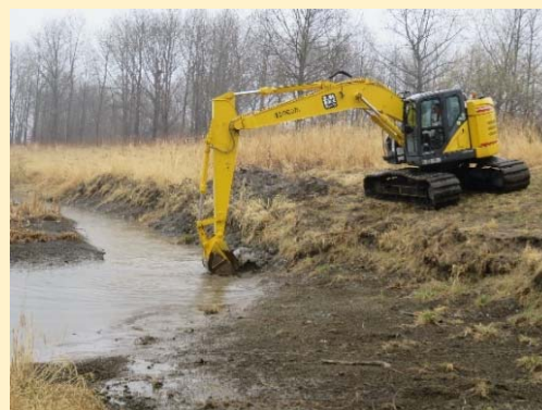
バックホウによる掘削開始（湿地上流右岸から）
