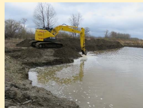
バックホウによる掘削開始（湿地上流右岸から）
