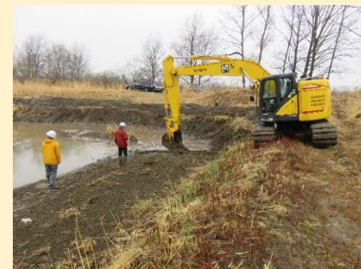
バックホウによる掘削開始（湿地上流右岸から）
