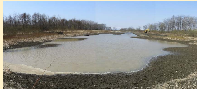
掘削後：湿地下流の水域
