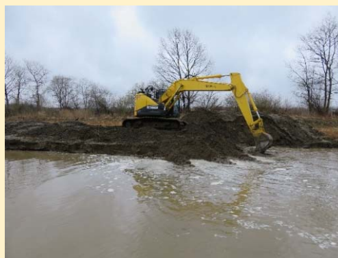
湿地上流左岸側の掘削
